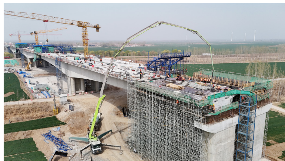
建设项目施工现场
