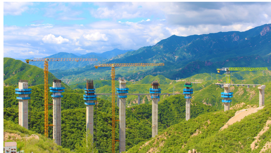
张涿高速与北京市 国道 G109 新线高速 连通工程建设现场
