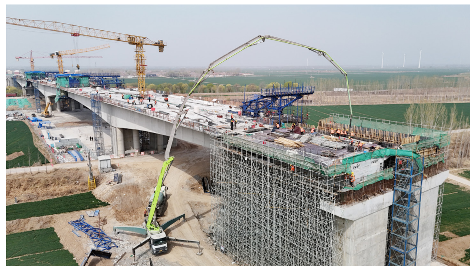
建设项目施工现场
